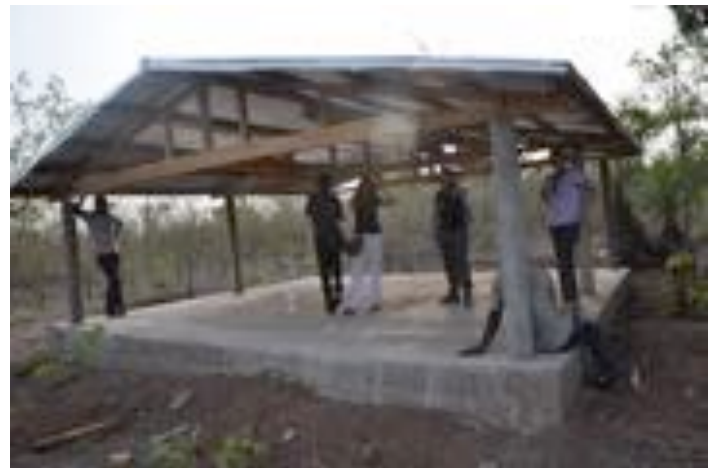
Future miellerie en construction
